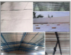
屋顶保温隔热
